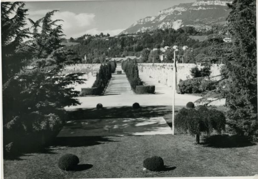
FIGURE 1 – Cimetière de Charrière Neuve en 1951 (source : Collection Ville de Chambéry - Documentation )
