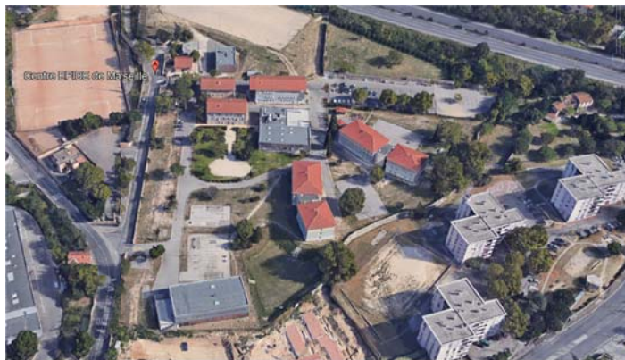
Vue aérienne Centre Epide Marseille (Google Earth)
